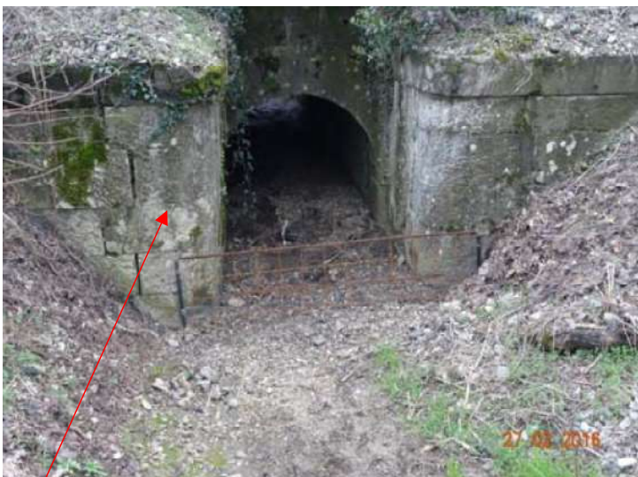
Attraversamento ferrovia UD-TS: spallette manufatto danneggiate
