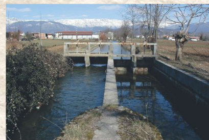
Divisione del canale che proviene dalla presa sul Torre nelle due rogge di Udine e di Palma in località Valle (Reana del Roiale).
